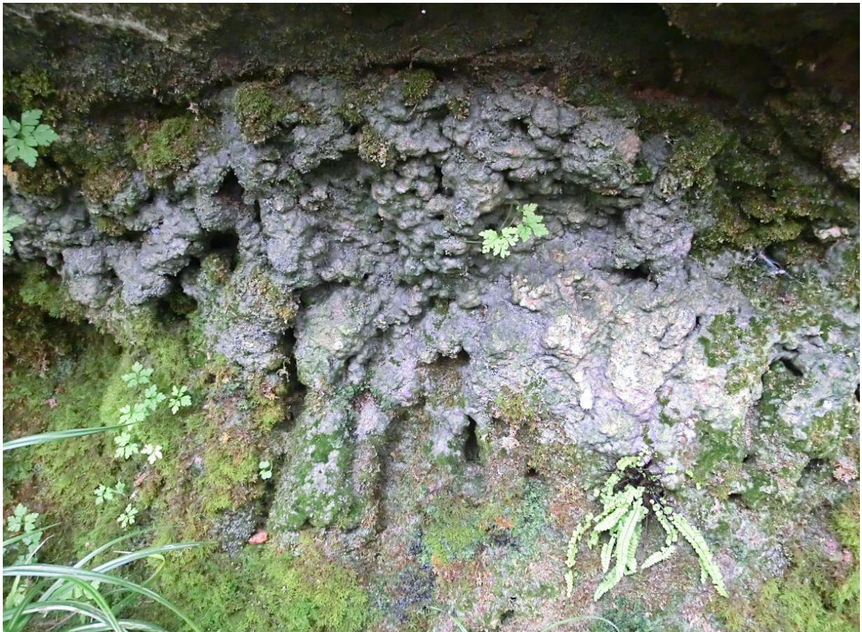
Abb. 13: Kleinflächige Kalksinterstrukturen am Oberen Felsenweg
